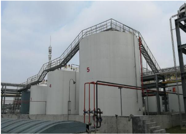
图 4.1-6 危险废物储罐区
