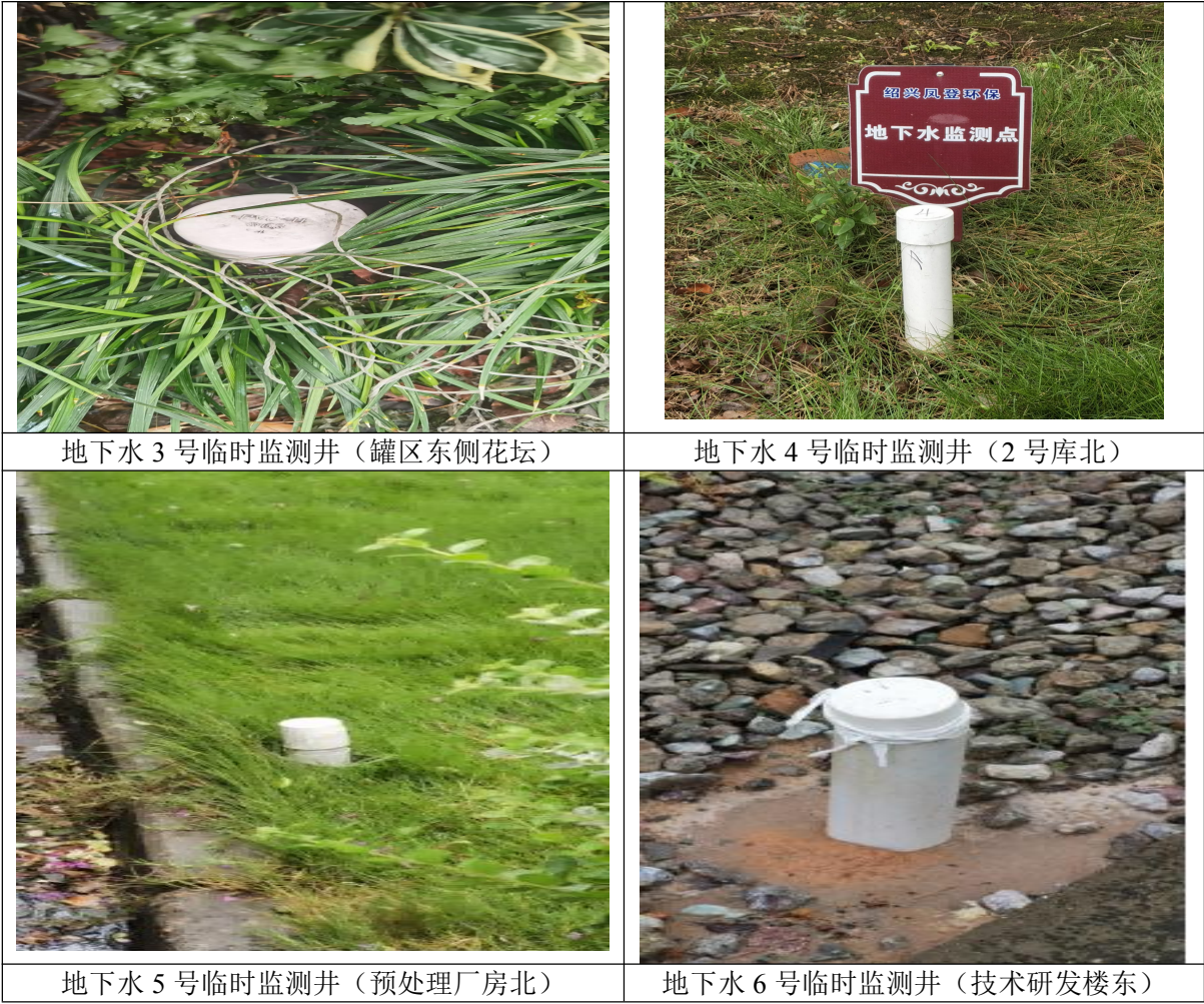
图 4.2-5 地下水监控井现场建设情况
